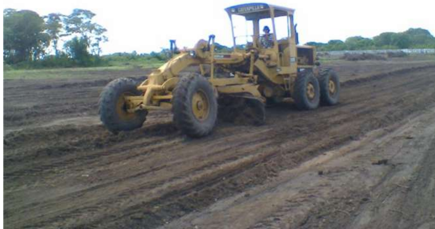
Figura 21 – Máquina trabalhando na terraplenagem da área
